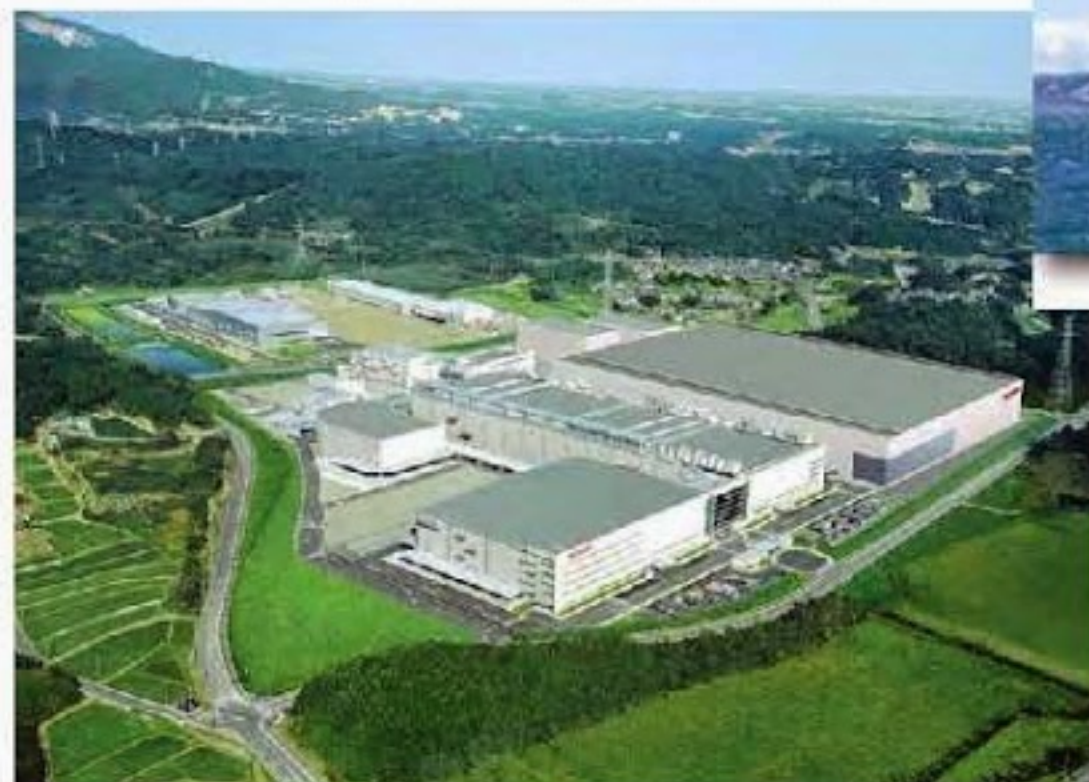
大型工場施設・IC工場鉄骨など
