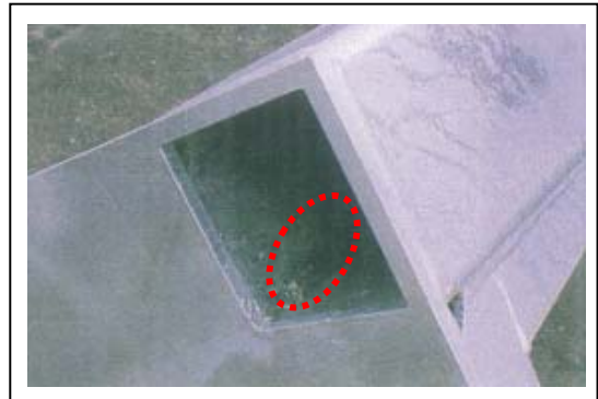
写真2 角パイプで作られた建屋部材 ベース開口部が角パイプ内径より小さいため垂鉛溜まりができる。
