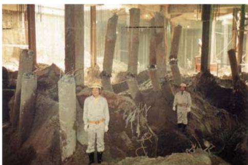
1964年新潟地震の液状化による建物杭被害(河村ら, 1985)
