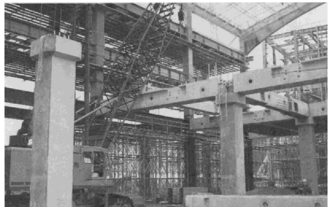
鉄骨架設完了でのPC架構組立て
