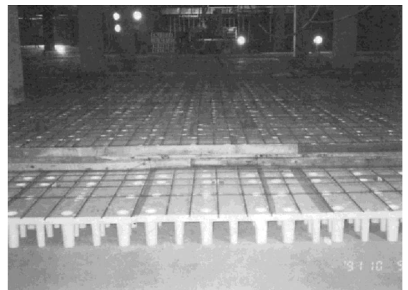
カジマ湧水パネル。この上部80~200コンクリート打設
