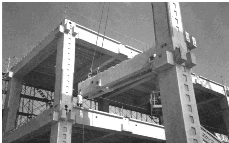
柱自立後大梁の組立て
