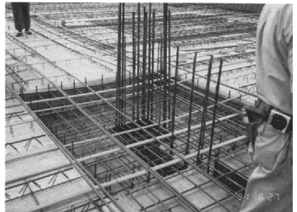
原則としてPC鋼線はオムニア筋と平行とする
