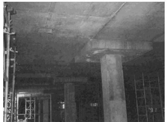
打設後のスラブ
