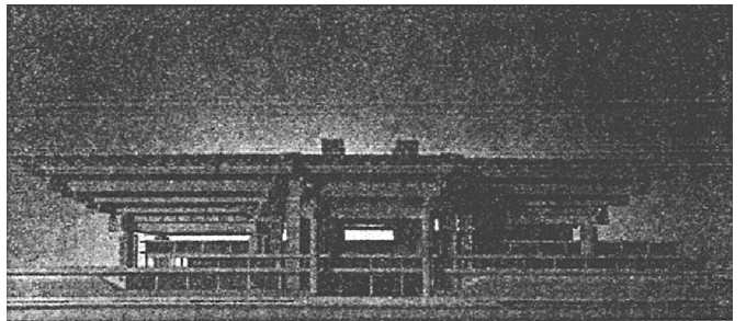
国立京都国際会議場 1963年コンペ案 菊竹清訓 設計 プレストレストコンクリートによる井桁組大架構
