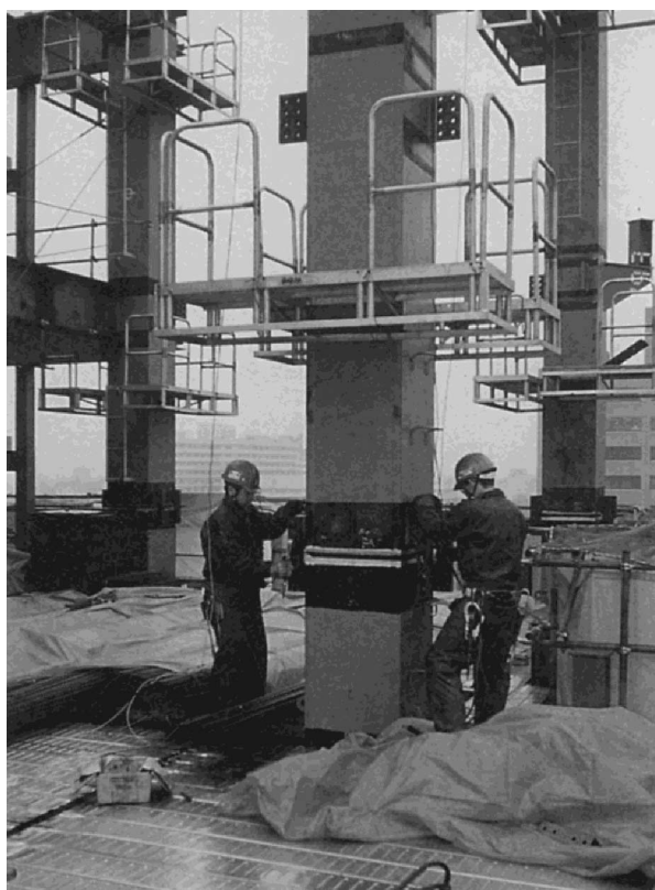
柱ボルト取り
