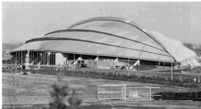
写真-1 ハマルオリンピックホール全景
