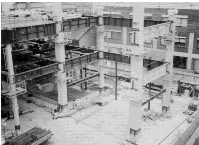
地上階鉄骨建方状況
