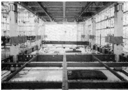
鉄骨地組状況
