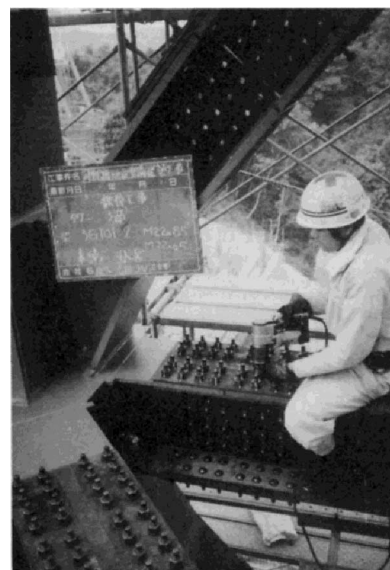
ボルト締め状況
