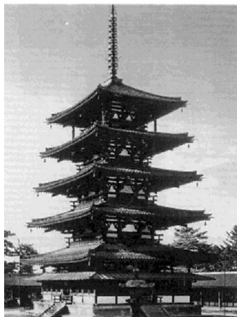
法隆寺五重塔全景
