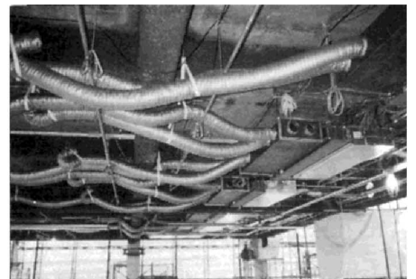
天井設備工事状況
