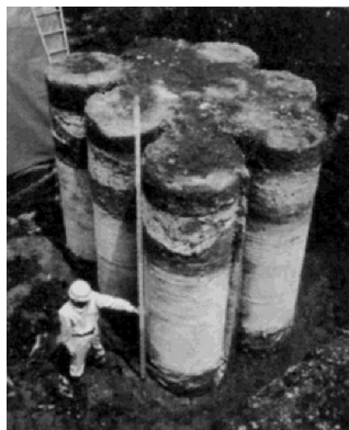
改良された地盤の掘り起こし状況
