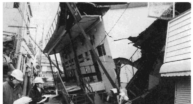
2年前にリニューアルした5階建のアパート 瞬時に1階が倒壊した
