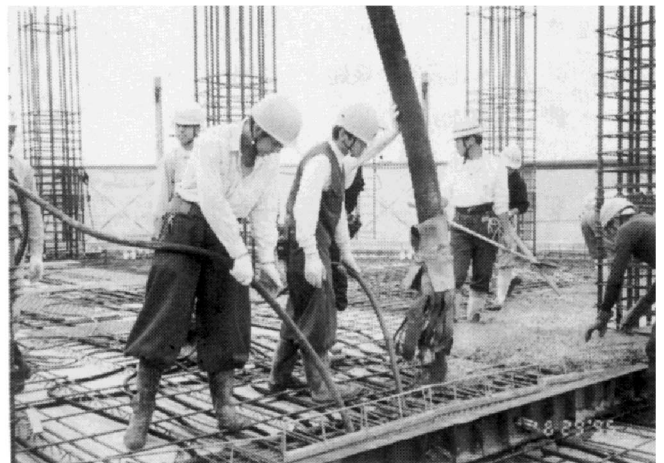
コンクリート打設
