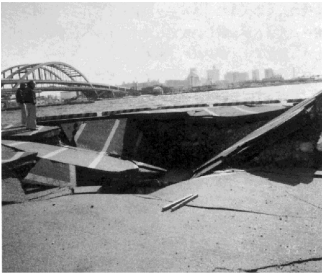
地盤沈下の激しい第3突堤
