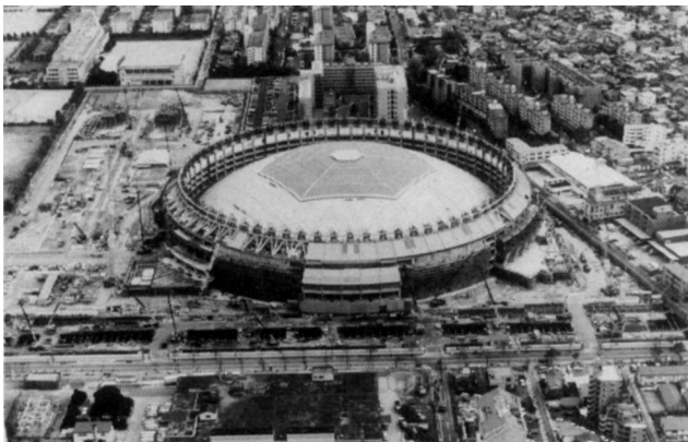
リフトアップ前工事全景
