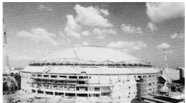
図-5 施工状況写真（リフトアップ前・後）
