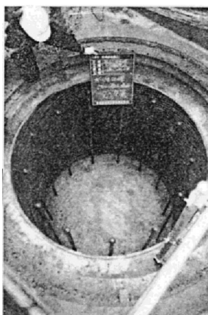
リブ付鋼管コンクリート杭
