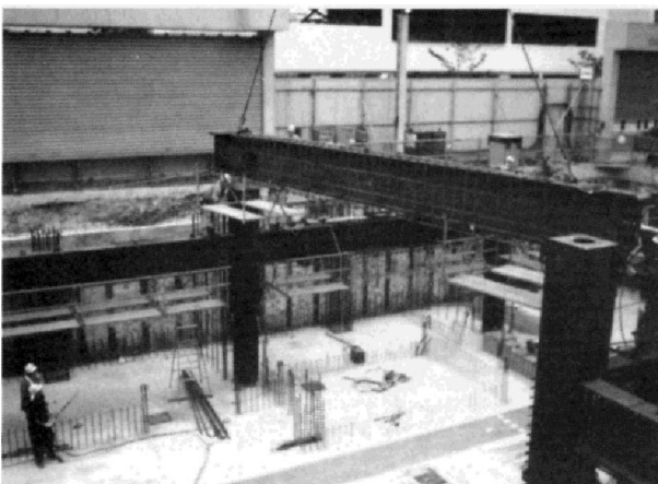
鉄筋先組み梁取付状況
