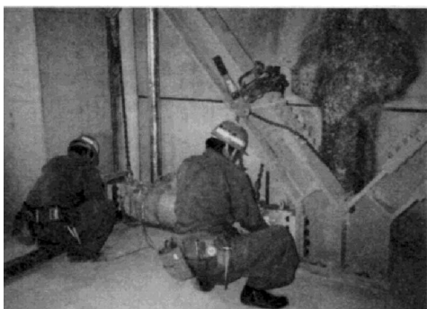
ハイダム取付状況
