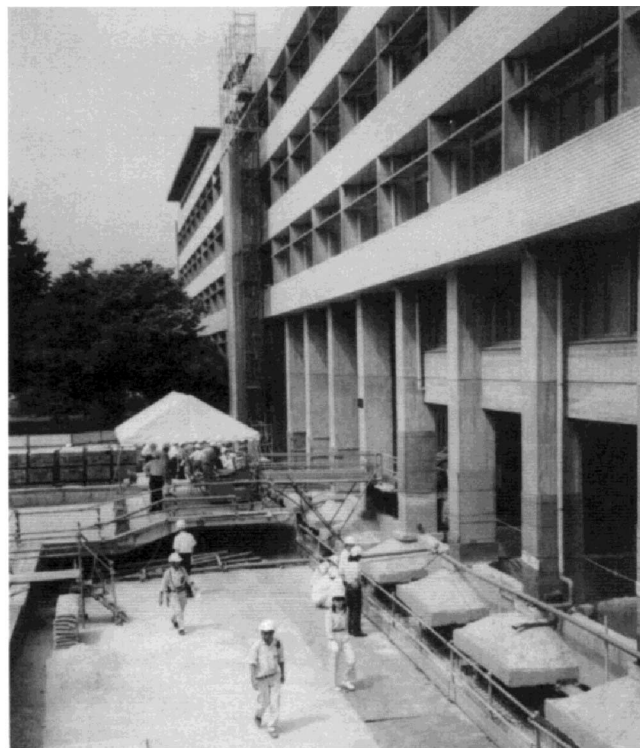
免震工事中写真
