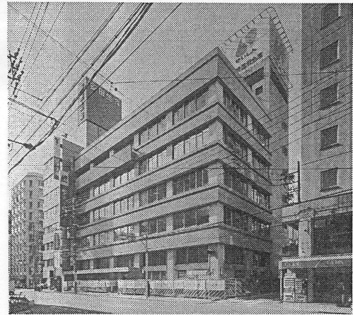
写真-1 既存建物の外観(1965年竣工)
