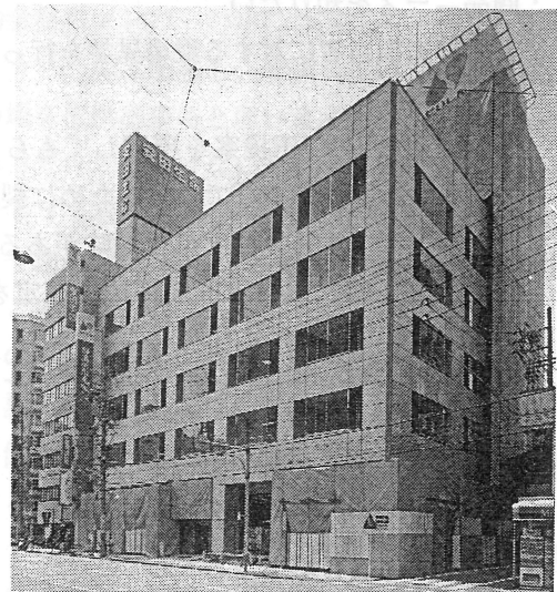
写真 - 6 耐震改修後の外観 (1階は施工中)
