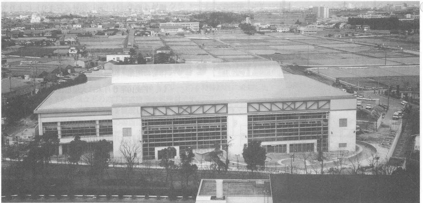
写真-1 建物外観
