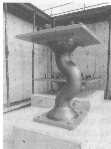
写真 3 鉛ダンパー設置状況
