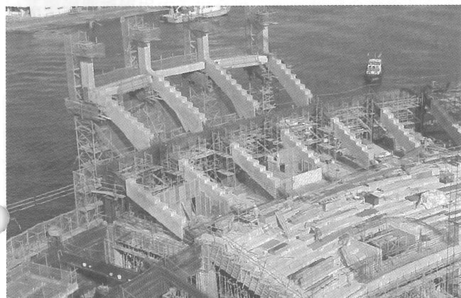
スタンド部PC梁架設状況
