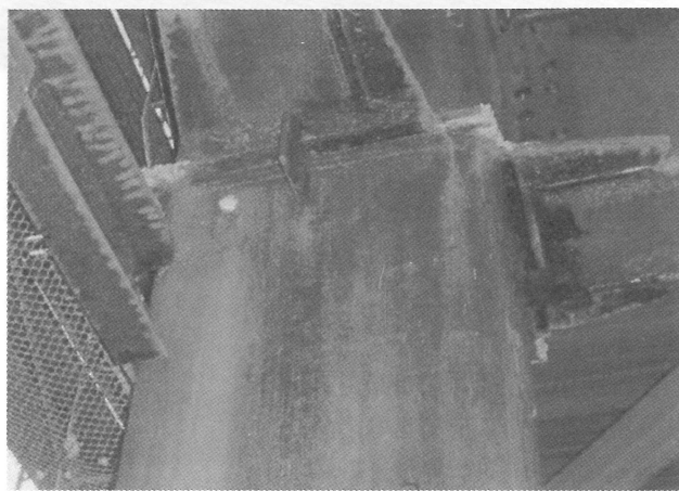
柱頭部蒸気抜孔状況
