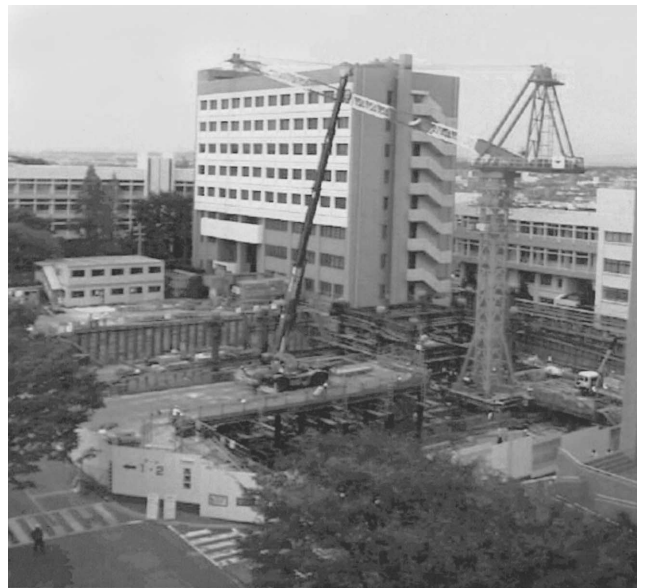
鉄骨建方状況(1節:8月末)
