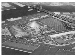
No.13 国際展示場3号館
