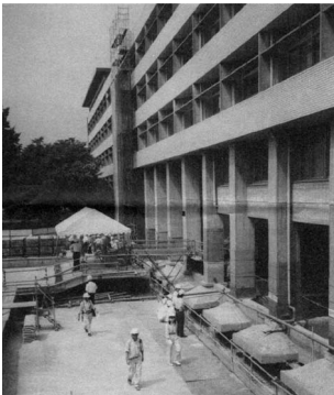
No.33 中部大学9号館 免震レトロフィット
