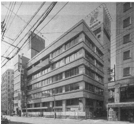
No.37 静清信用金庫本店 耐震補強
