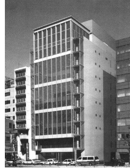
No.35 名古屋大林ビル
