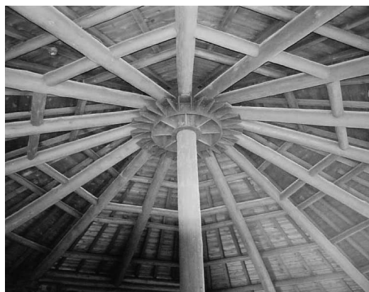
屋外炊飯棟 煙抜きを兼ねた取り付け具 外周柱・方杖等ほぼ丸太材のみ
