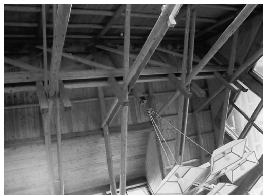
コルリ 丸太材を多用した構造 丸太と丸太半割と角材との組み合わせ
