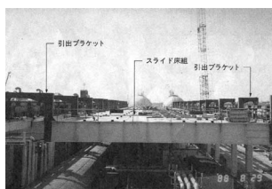
No.5 大型鉄骨のスライディング工法
