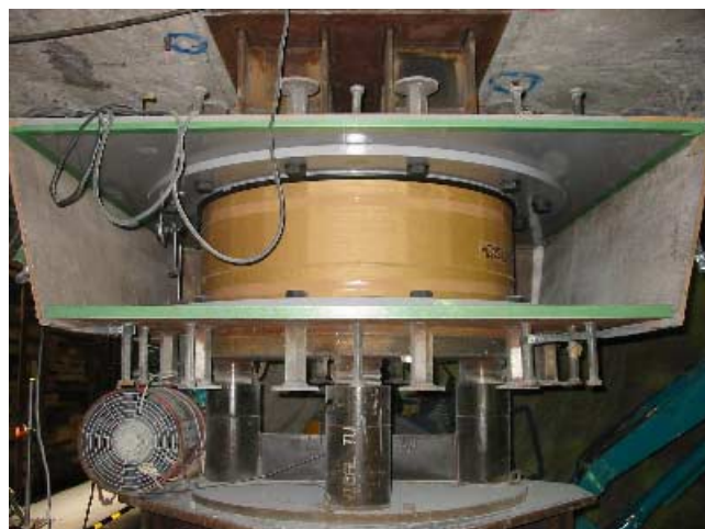
「油圧ジャッキにて、上部の荷重を支持した状態」
