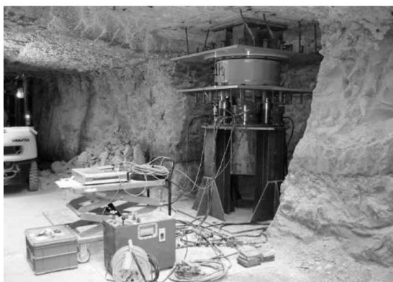
免震架台設置、油圧ジャッキにて荷重移行
