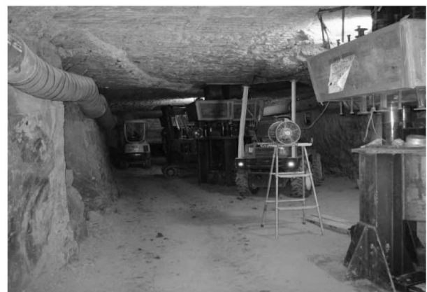
掘削および床付作業
