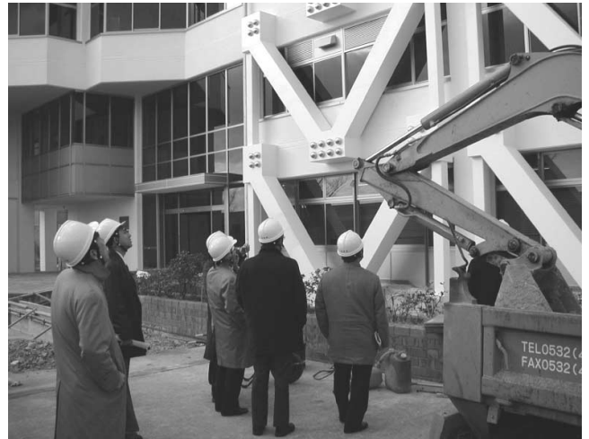
PCa ブレースの取付状況
