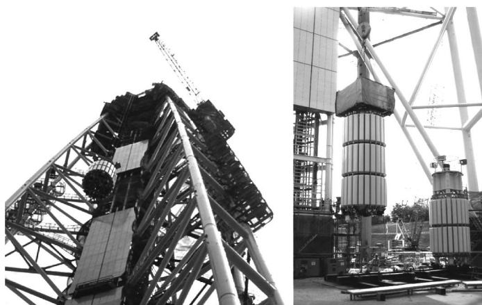
アンテナ塔の建方状況
