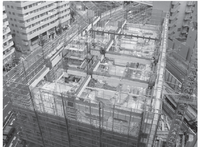
RC 積層工法 (ハーフ Pca 梁セット)
