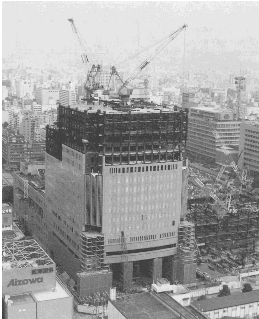
NHK 名古屋放送センタービル 工事全景
