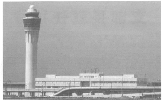
図1 中部国際空港庁舎・管制塔 ( http://www.centrair.jp/ より)
