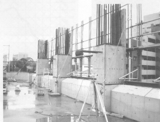
外周フルPC柱建て込み状況
