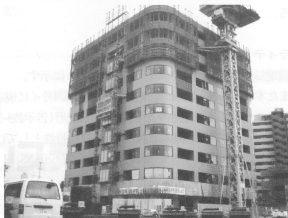
工事状況全景
