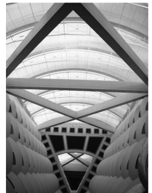
バージュ・アル・アラブの内部
