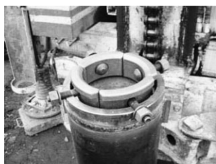
写真-1 CCジョイント継手
