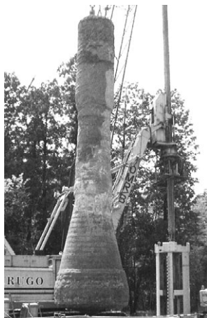
掘り出された試験杭
