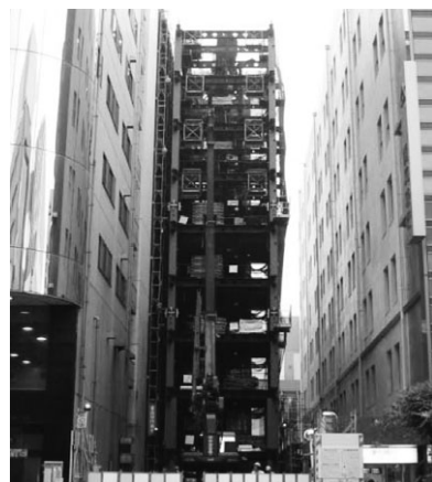
鉄骨建方状況
