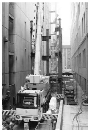
柱建起し機による建方
