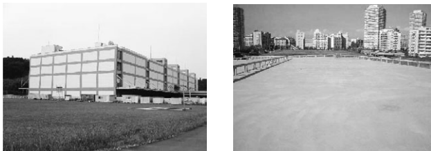
「コンクリート膨張材」施工例
