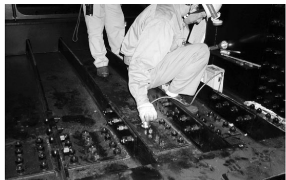
超音波ボルト軸力計による測定状況
