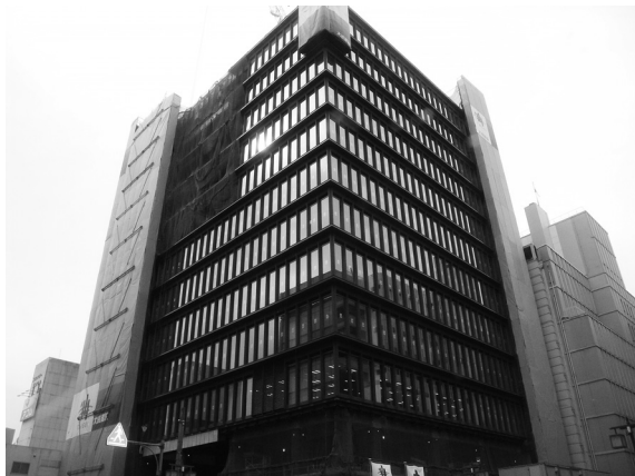
図-1 平成21年9月末の現場状況
