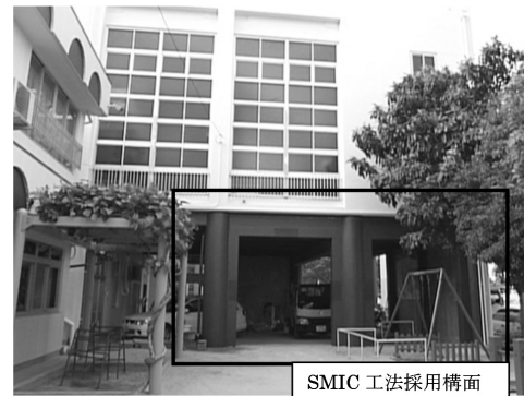
図2 補強後外観写真
