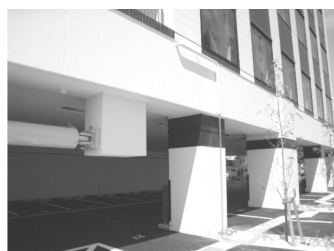
免震層完成時写真
