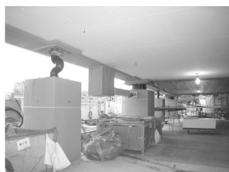
免震層施工時写真
