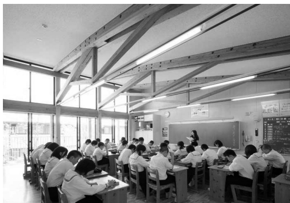
写真1：製材とテンションロッドで構成した普通教室棟のトラス材
