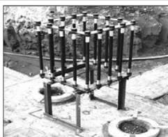
JSS 建築用露出柱脚フレーム施工
