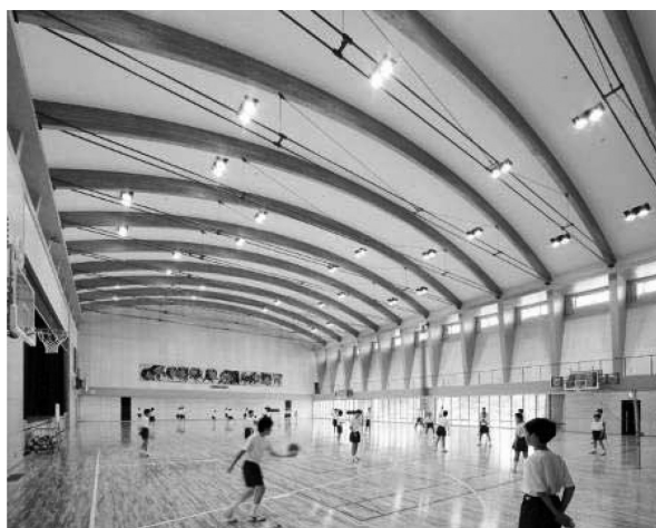
写真4：集成材によるアーチ梁とタイバーによる体育館屋根
