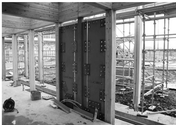
写真2：鋼板耐震壁
