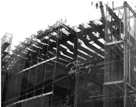
写-2 吊架構部建方状況
