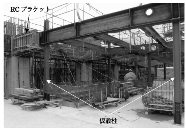
写-1.鉄骨建て方状況
