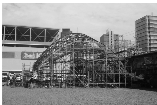
写真-2 キャンパスモール先行施工の状況
