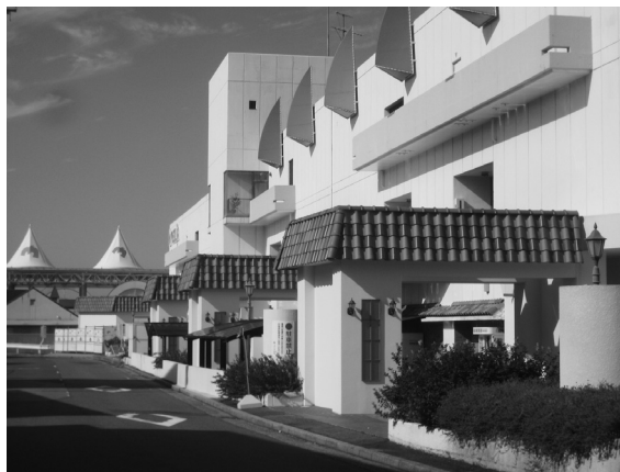
地上部完成状況
