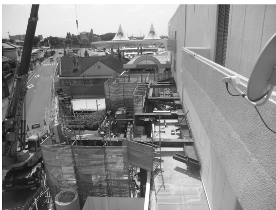
地上部施工状況
