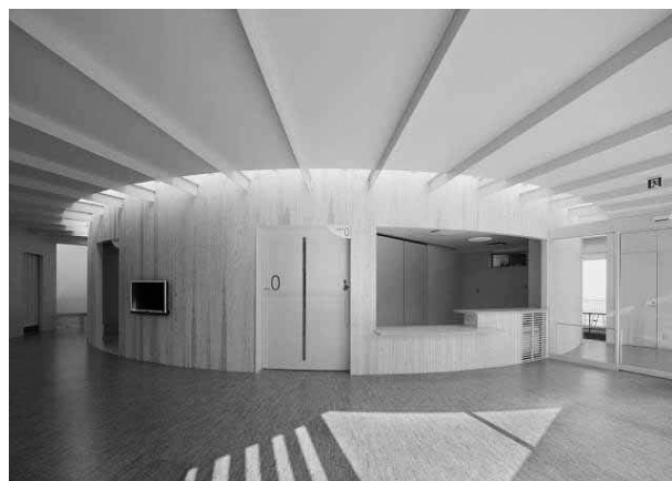
写真3:カットT梁設置状況
