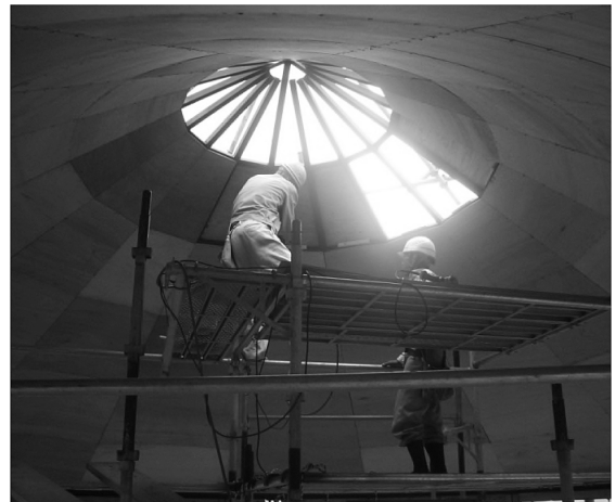
軒レベルより順次外→内と順番に合板を張っていく。
