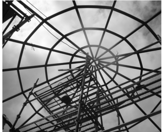
鉄骨フレームの組み上げ状況リング状の部分は合板面と角形鋼管の面が合うように測地線方向に調整されている。
