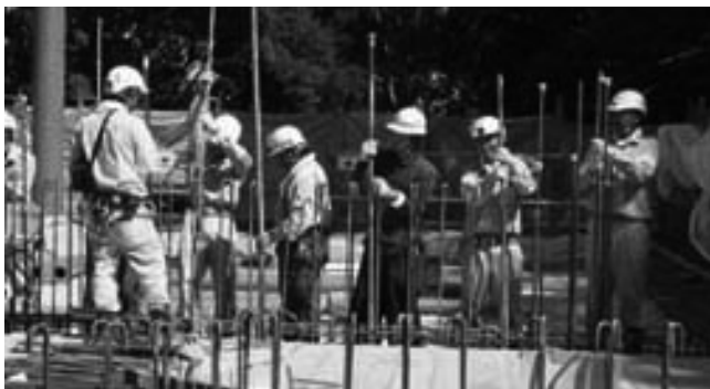
打放しコンクリート打設風景
