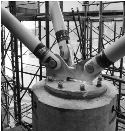
写真2 RC柱とS柱の接合部
