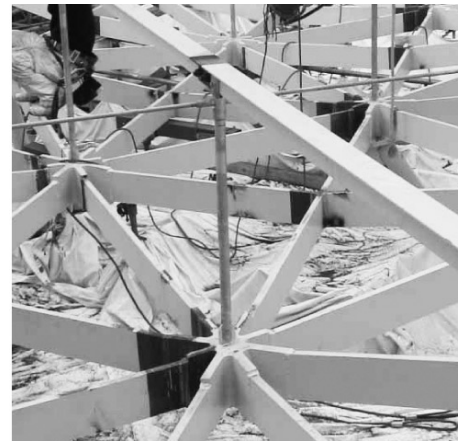
写真4 ガラスサッシ支持部
