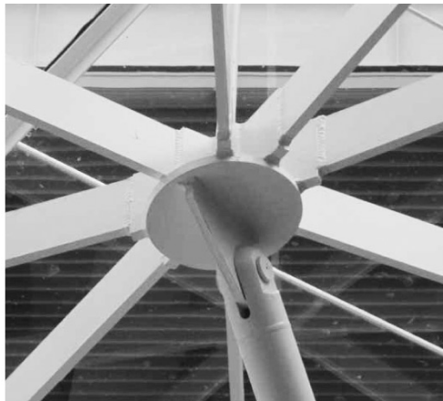
写真3 S柱と円筒形ラチスシェルとの接合部
