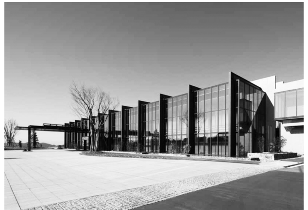
北東方向からの全景
