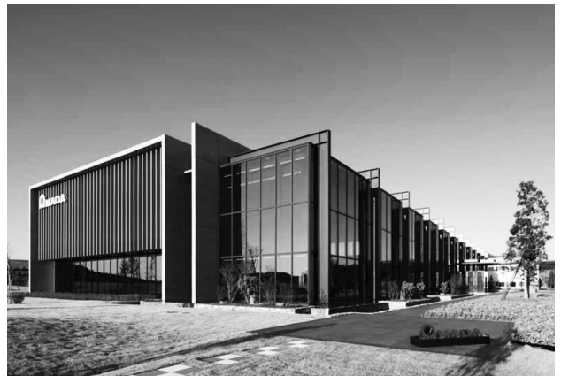
南東方向からの全景
