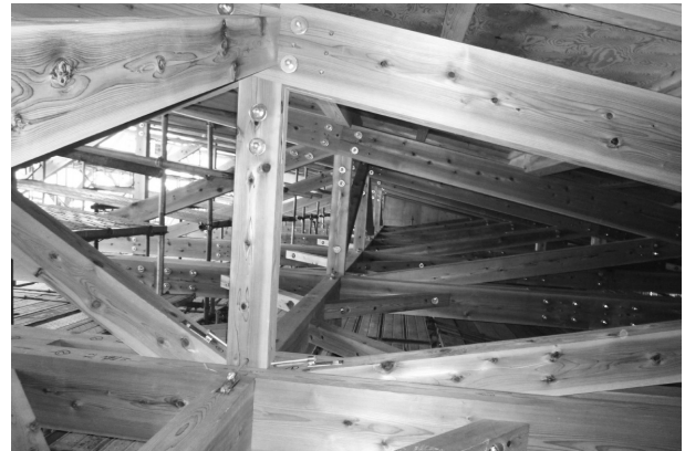
写真4:トラス接合部
