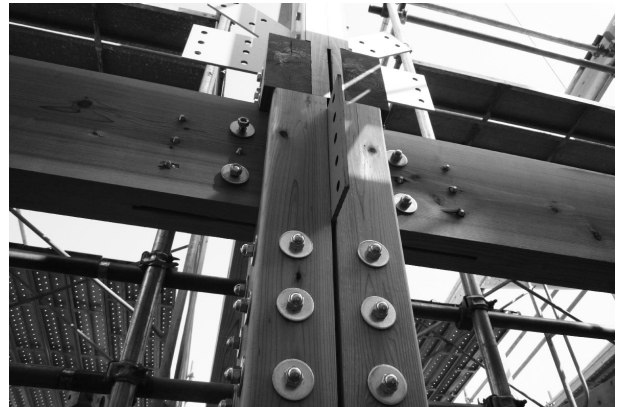
写真5:接合部(柱-トラス-桁梁)
