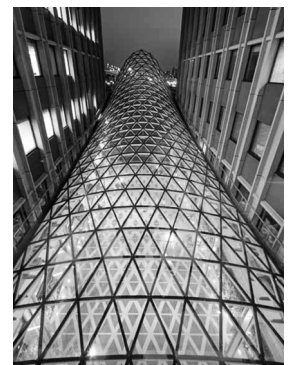
写真4 屋根上面夜景
