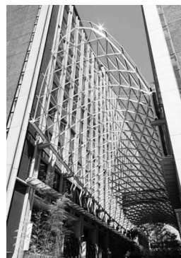
写真3 西端部屋根見上げ
