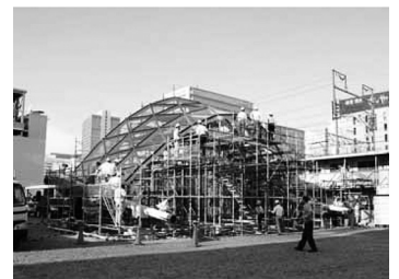
写真2 先行仮組施工
