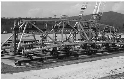
写真3：鉄骨地組状況
