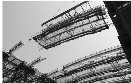
写真4：鉄骨建方 中央ピース取付
