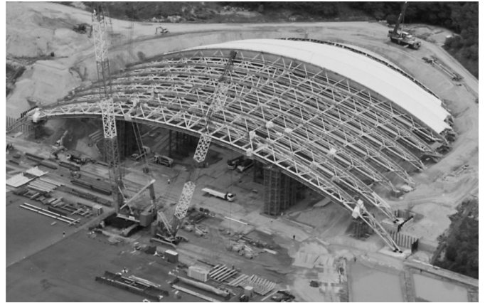
写真2：鉄骨建方 完了時
