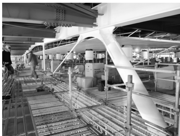
写真-4 アリーナ施工時
