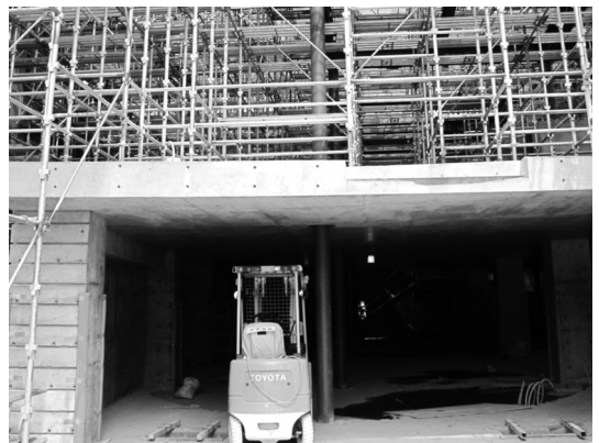
写真-6 棚田テラス施工時
